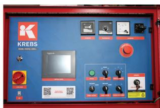
São completos e de operação simples, com todas as funções necessárias para o controle completo do pivô: sentido, bomba injetora, lâmina em centímetro ou em milímetros. O modelo de entrada 5001 já conta com os componentes digitais Keltrics. Eles oferecem maior precisão na hora de configurar a lâmina ou o pressostato.
